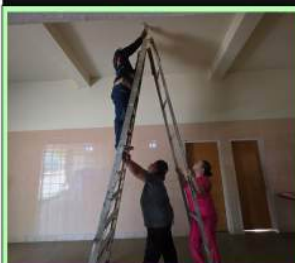
Alcaldía de Piar ejecuta trabajos de saneamiento en el Ambulatorio Rural Tipo II de El Manteco
