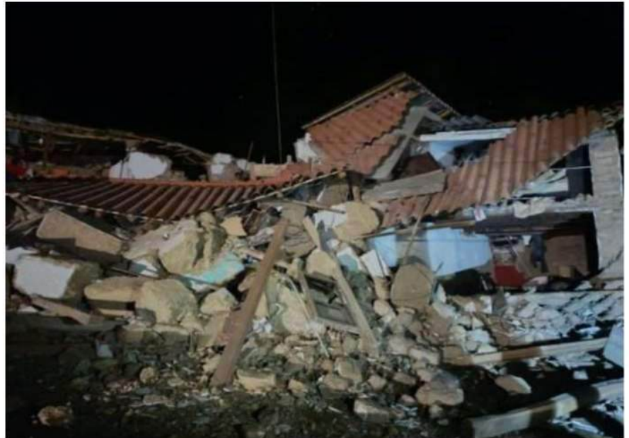
El temblor con epicentro en Chongos Bajo destruyó 48 viviendas y afectó centros de salud, templos y el servicio eléctrico
