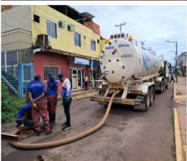
Despliegan plan de saneamiento en la red de aguas servidas del municipio Gran Sabana
